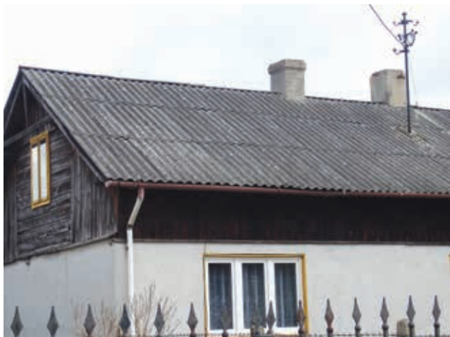
Fot. 1. Dach budynku mieszkalnego pokryty eternitem.
