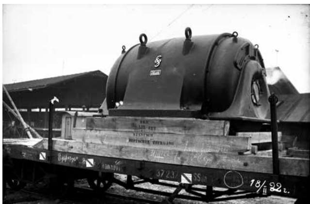
Fot. 3. Transport elementów elektrowni – odgazowywacza (po lewo) i stojana prądnicy (po prawo) (fot. Wiktor Jekimenko, źródło: Archiwum Veolia)
