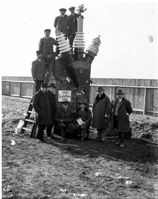
Fot. 5. Słup stacji transformatorowej (fot. Wiktor Jekimenko, źródło: Archiwum Veolia)
