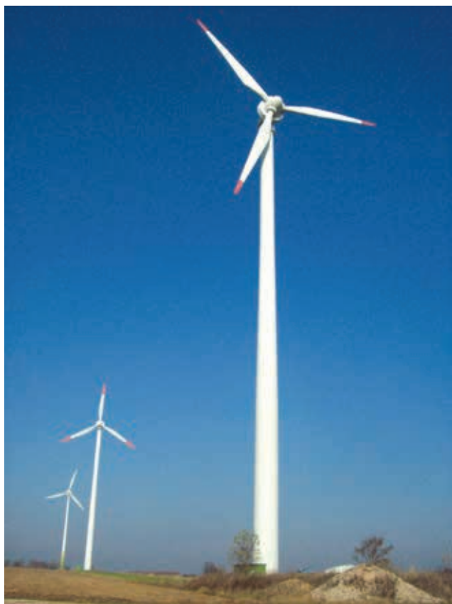
Fot. 1. Przedmiot badań – turbiny o mocy po 0,5 MW produkcji firmy Enercon GmbH (fot. G. Wągorowski)
