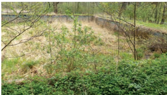
Rys. 3. Pozostałości basenu w sąsiedztwie zbiornika Rochna, fot. własność Autorów
