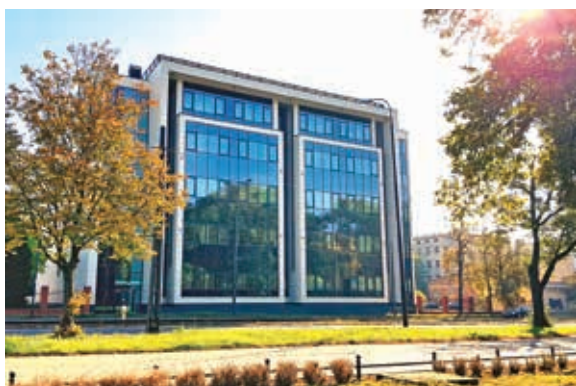
Gmach Alchemium, część administracyjno-dydaktyczna, widok od ul. Żeromskiego, 2021 r.
